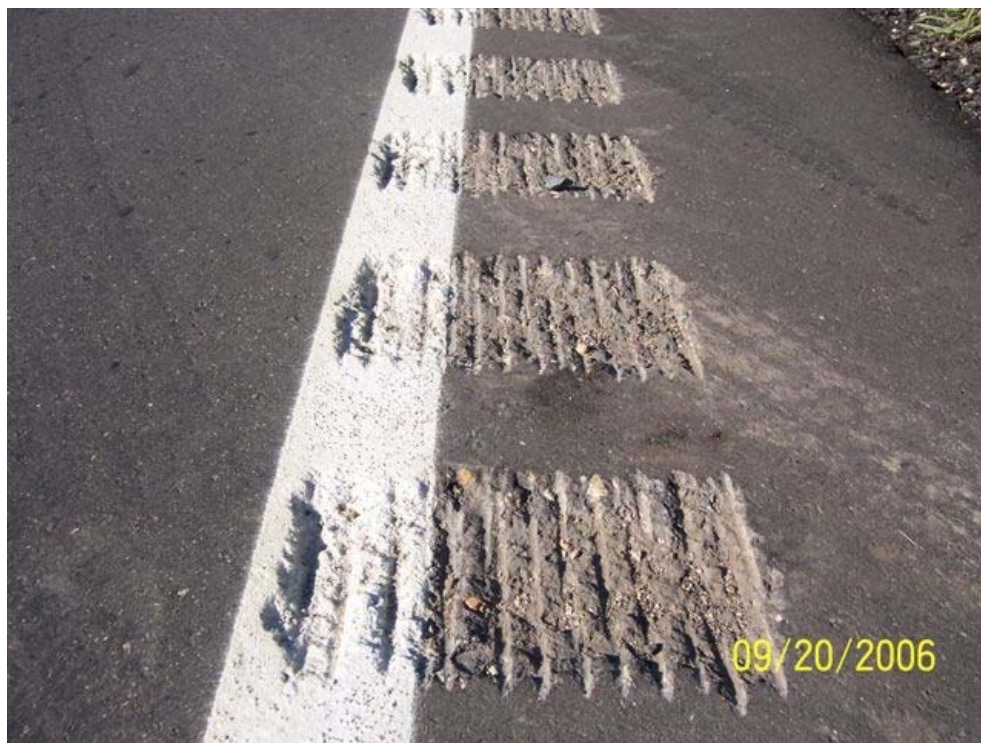
Figure 1.1. Edge line rumble strip
