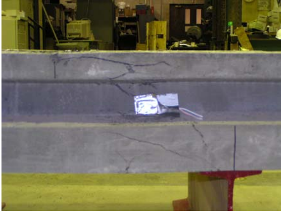
i. Beam C2.
