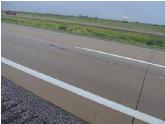
Longitudinal cracking
