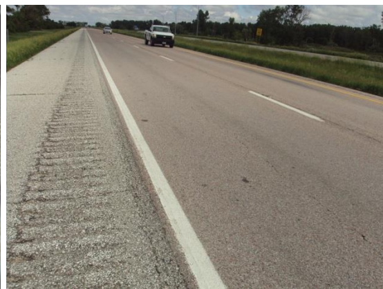
Longitudinal cracking
