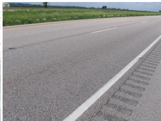
Longitudinal cracking
