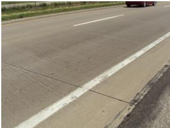
Longitudinal cracking
