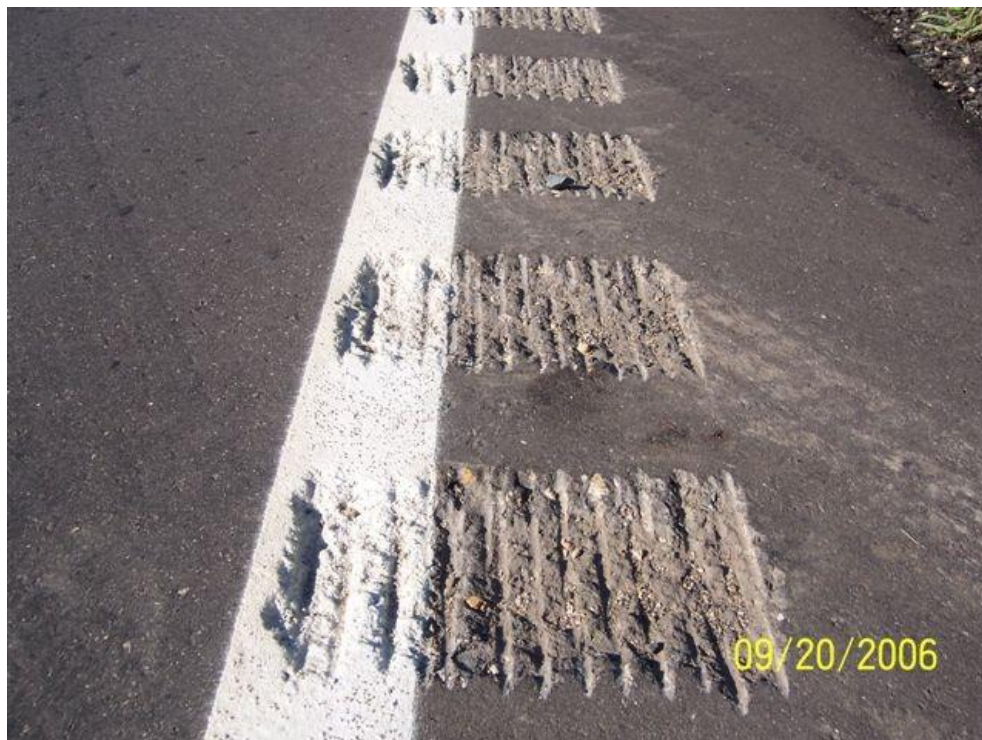
Figure 1.1. Edge line rumble strip
